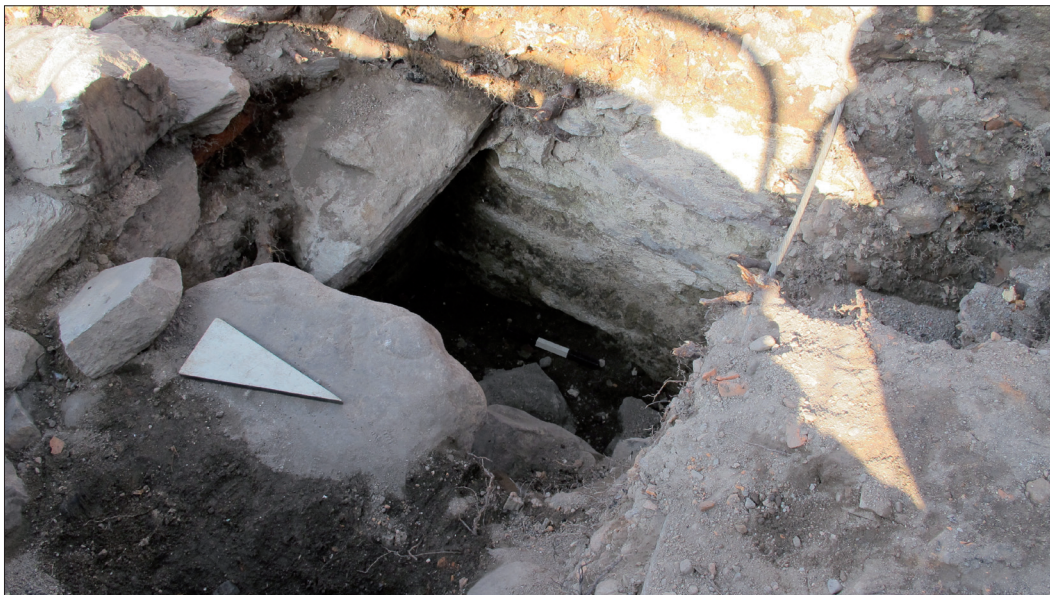
Figur 34: Närbild av den västra väggen i källaren A630 med fundamentstenen till kryssvalvet i hörnet. Foto från nordöst.
